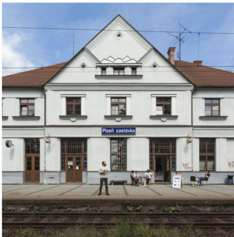
Zastávka Původně železniční stanice Česká republika | Plzeň
